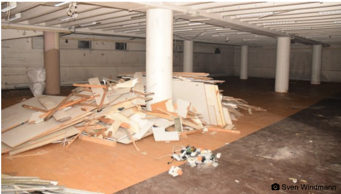
So sah das Gebäude vor dem Abriss von Innen aus.
